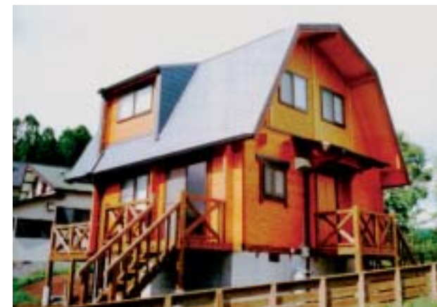
M邸施工例(宝泉寺)ーマンサード屋根タイプ
